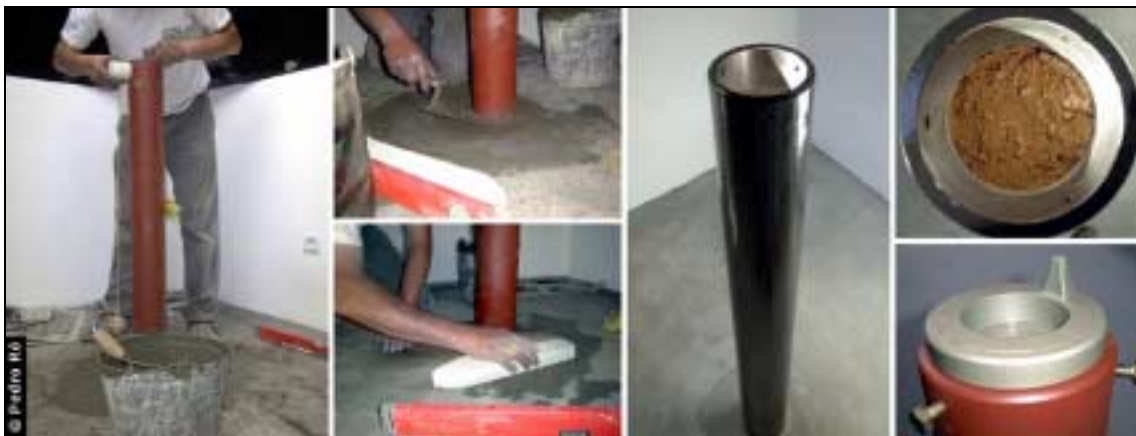
Figura 3- Pilar instalado no interior de um observatório.
